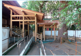
社殿北側 スロープ設置
