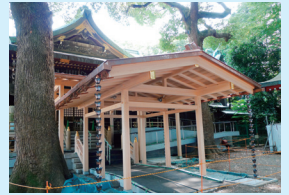
社殿北側 屋根掛
